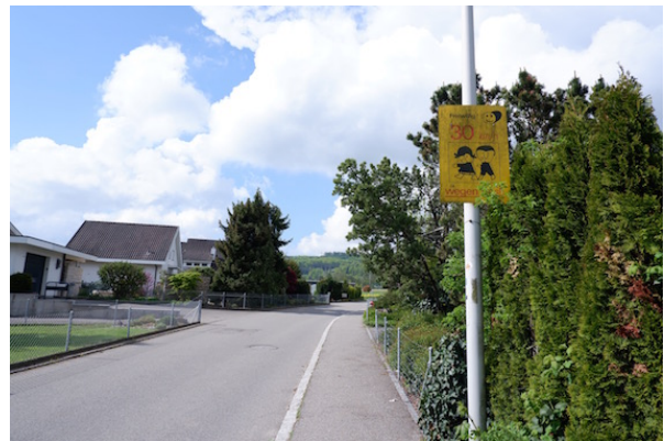
Fahrbahn 4.50m, Trottoir 1.50m, eingeschränkte Sichtverhältnisse
