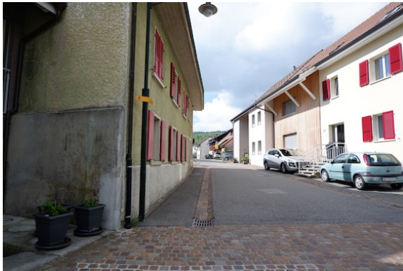
Trottoir 1.05m und Fahrbahn 2.95m
